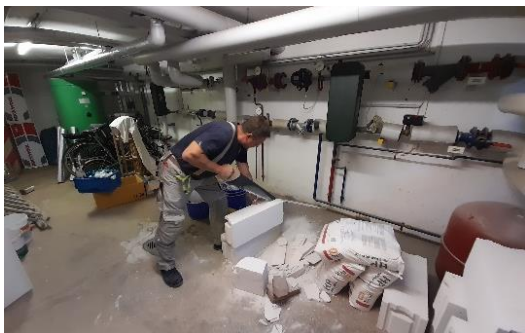
Strangsanierung Berliner Straße 180-186
