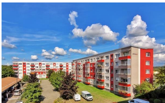
Fassadensanierung Berliner Straße 180-186
