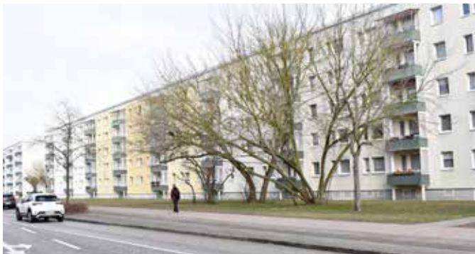
Im Konzept ist der Start der komplexen Quartierssanierung mit diesem Block J.-Marchlewski-Ring 18 bis 32 für die Jahre 2026/27 vorgesehen. Das Haus (rechts) hat acht Aufgänge mit insgesamt 77 Wohnungen, darunter eine 5-Raum-Wohnung. Links im Hintergrund: das Haus J.-Marchlewski-Ring 32 a-d, dessen Sanierung für 2027/28 anvisiert wird.
